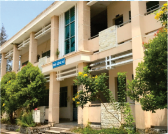
Hình 4. Công trình hiện hữu
