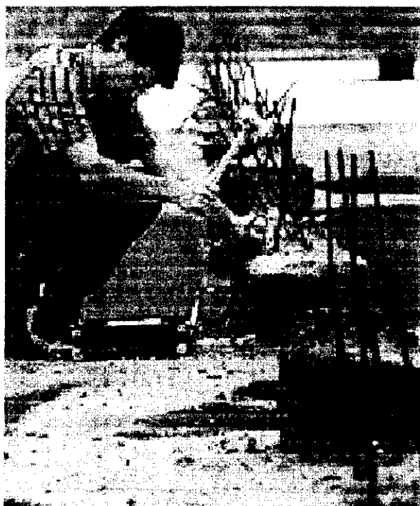
Hình 5.23. Thí nghiệm PIT
