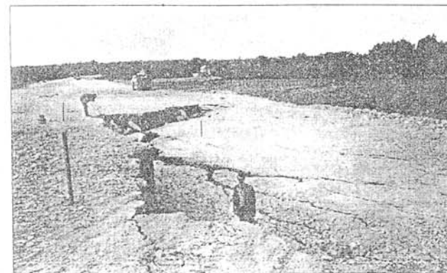
Hình 4.2a: Trượt sâu của nền đường ô tô cao tốc ở Caen (Pháp)
