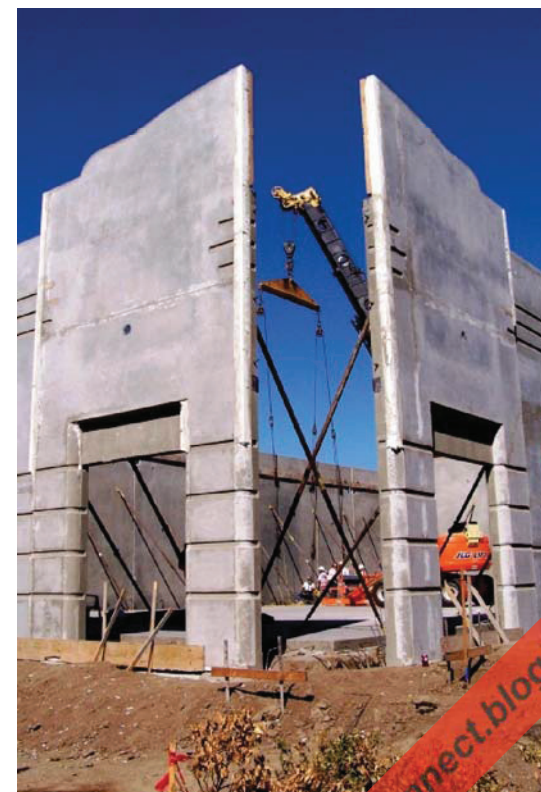
Hình 3.37. Cách liên kết panen tường sườn ô cờ
